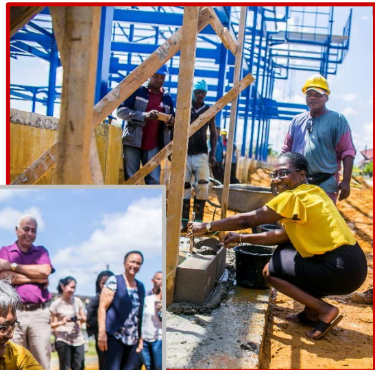
De eerste steenlegging door de bestuursleden
